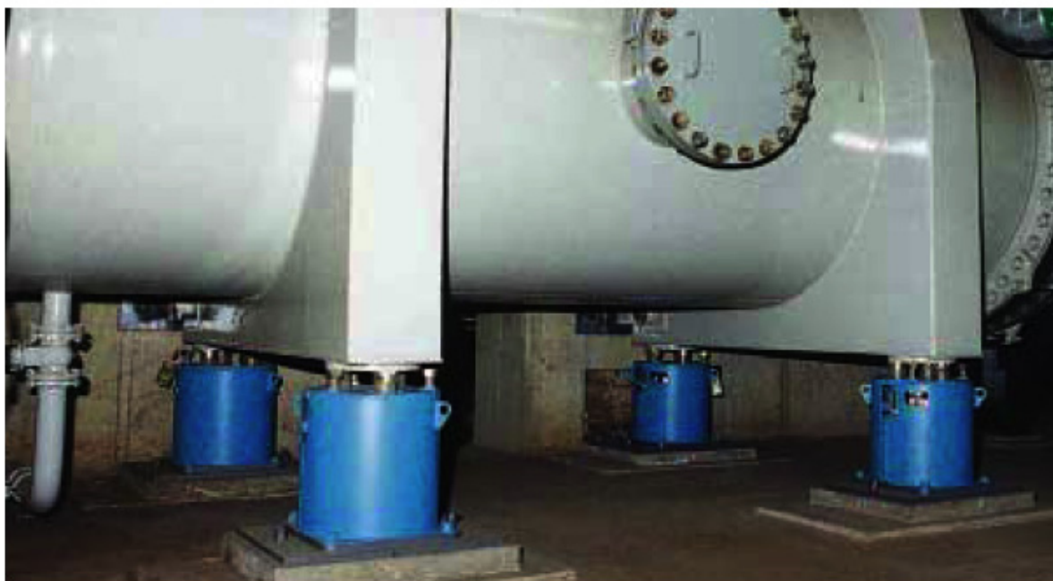
Slika 17. Primjer primjene elastičnog oslonca tip 28
