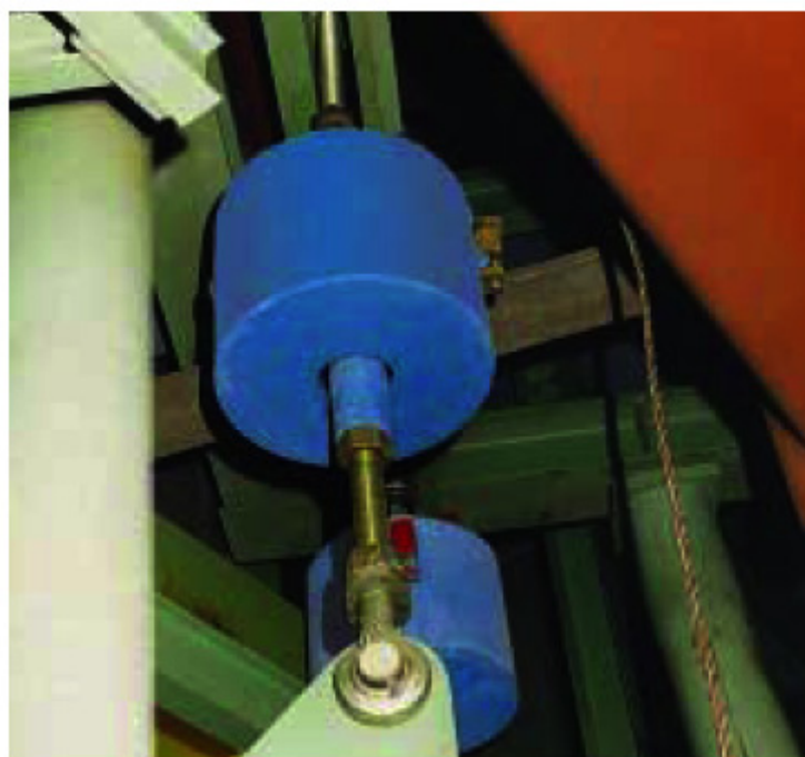
Slika 13. Primjer primjene elastičnog ovjesa tip 22
