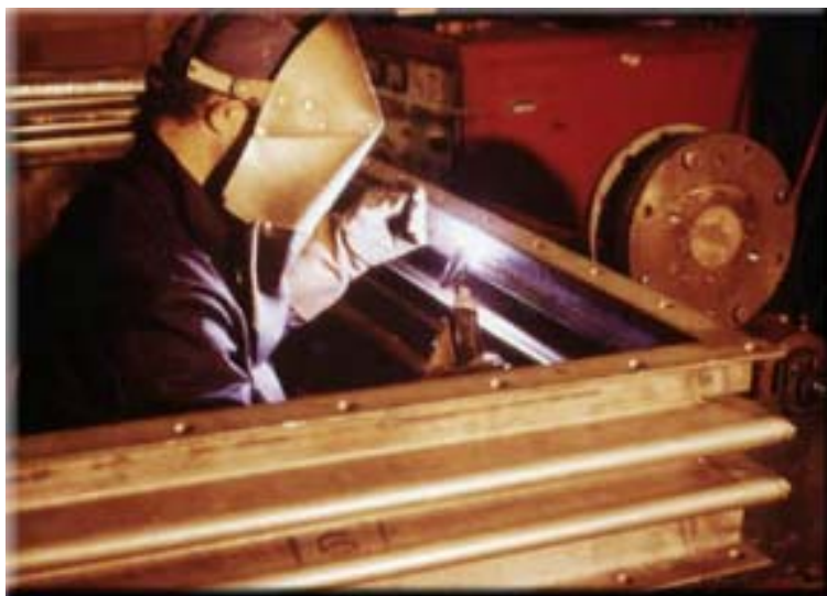
Slika 1.19 Zavarivanje pravokutnih kompenzatora TIG postupkom [1]
