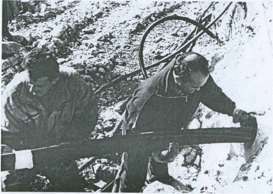
Ugradnja sidrišne dionice sidra S-7
