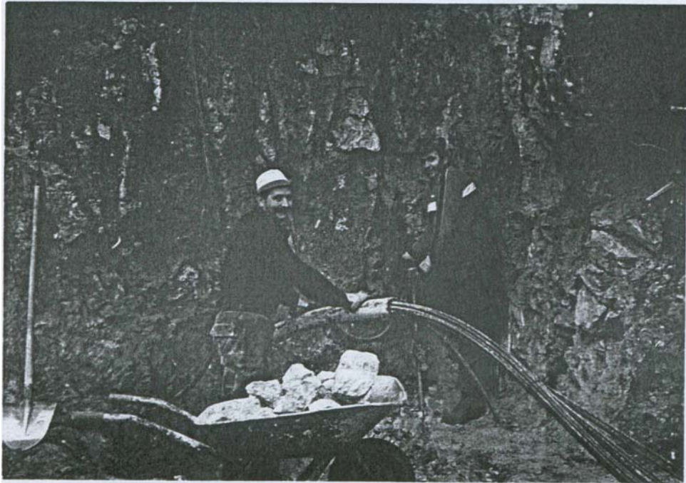
Iskop za sidrišni blok - blok sidra S-II
