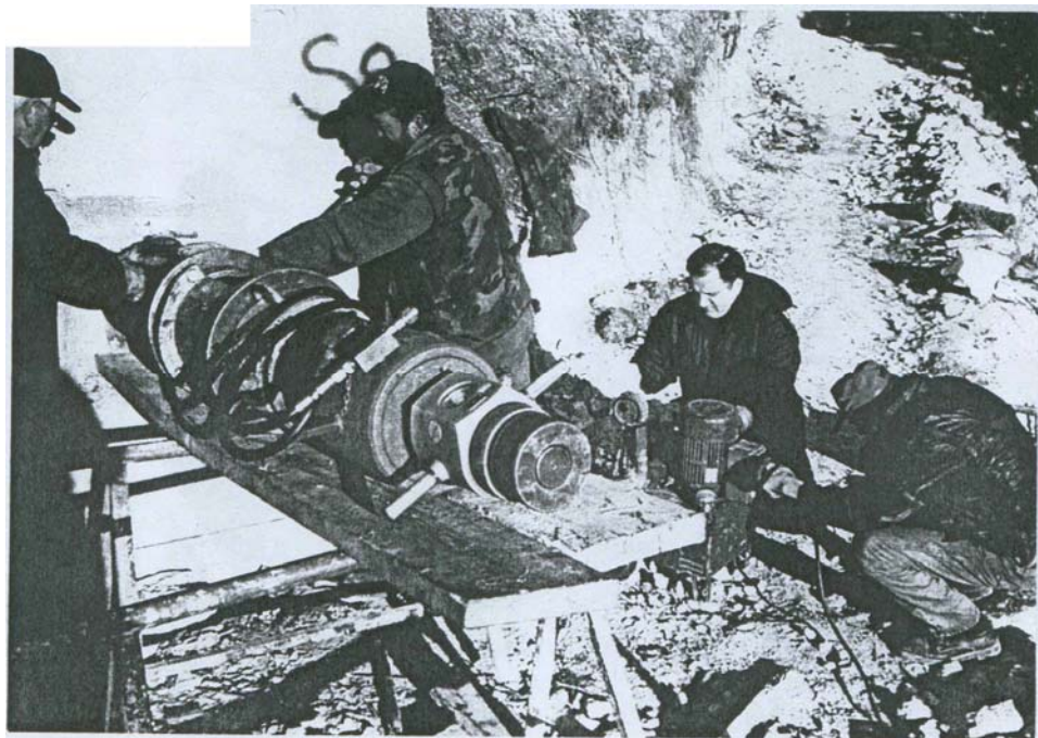
Priključivanje hidrauličke pumpe
